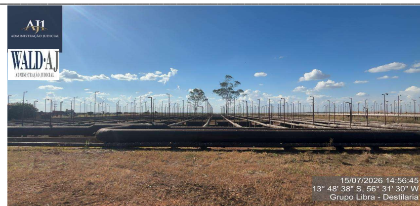
Figura 16 – Sistema De Resfriamento C/552 Aspersores C/Tubulacao Em Aco Carbono C/Diam 10 Pol Comp 500000 Mm – C
