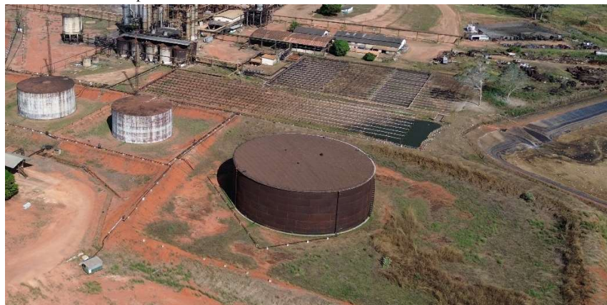
Figura 11 – Tanque Cilindrico Vertical P/Alcool Estrutura Em Aço Carbono Cap 20000 M3 Mca Sermatec
