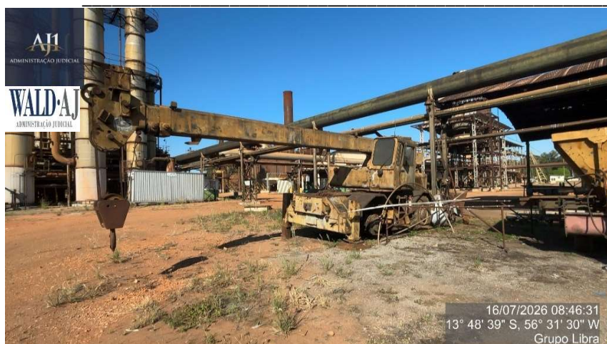
Figura 178 - Imagem Do Equipamento Grua Movel (Grover).
