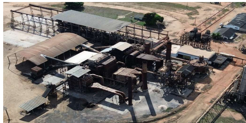
Figura 9 – Base De Concreto Da Área De Caldeira Com Volume De Concreto Da Estrutura 1.382,00 M 3
