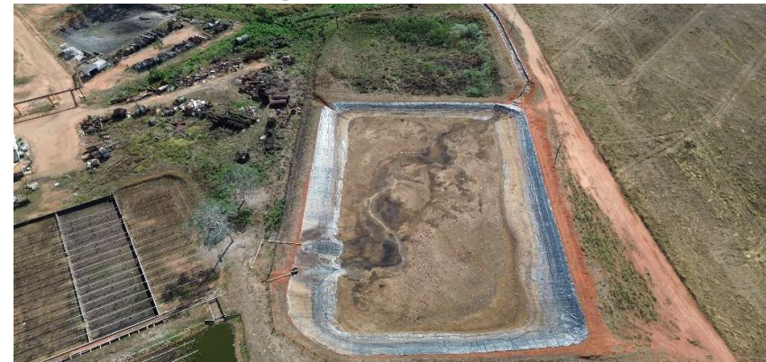
Figura 17 – Base De Concreto Decantação Com Volume De Concreto Da Estrutura 668,16 M³
