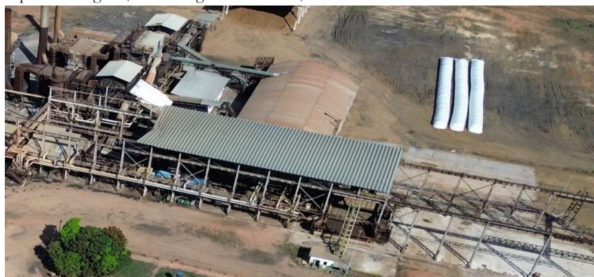
Figura 15 – Cobertura Barracão Moenda Com Área 3.082,00 M²
