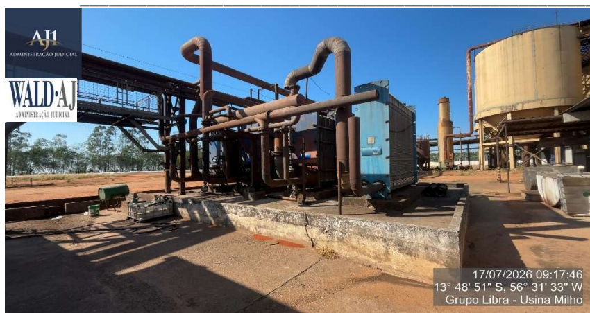
Figura 42 – Trocador De Calor Estrutura Aco Carbono Vertical Dim 1200x2000x1800 Mm Area De Troca 130 C Mca Alfa
