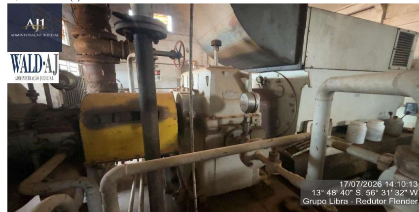
Figura 41 – Redutor De Velocidade Relação 6023-1800 Mca Flender
