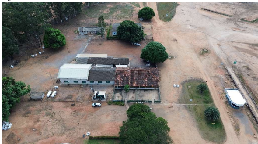
Figura 31 – Prédio Refeitório Com Área Privativa 866,05 M²
