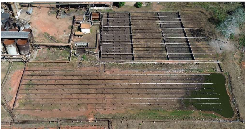
Figura 6 – Reservatório Em Concreto Tanque Spray 1 Com Volume De Concreto Da Estrutura 4.030,00 M 3
