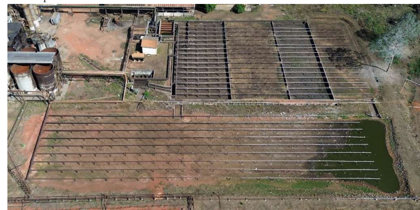
Figura 5 – Reservatório Em Concreto Tanque Spray 2 Com Volume De Concreto Da Estrutura 5.040,00 M³
