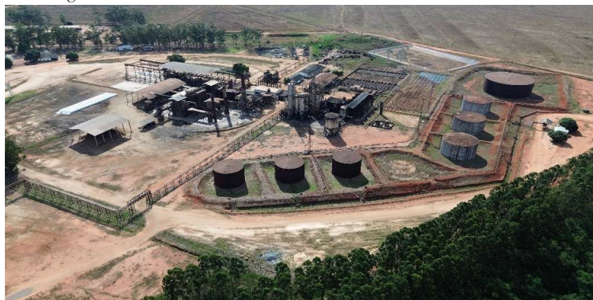
Figura 39 – 3 Unidades De Tanque Cilindrico Vertical P/Alcool Estrutura Em Aco Carbono Cap 3000 M3
