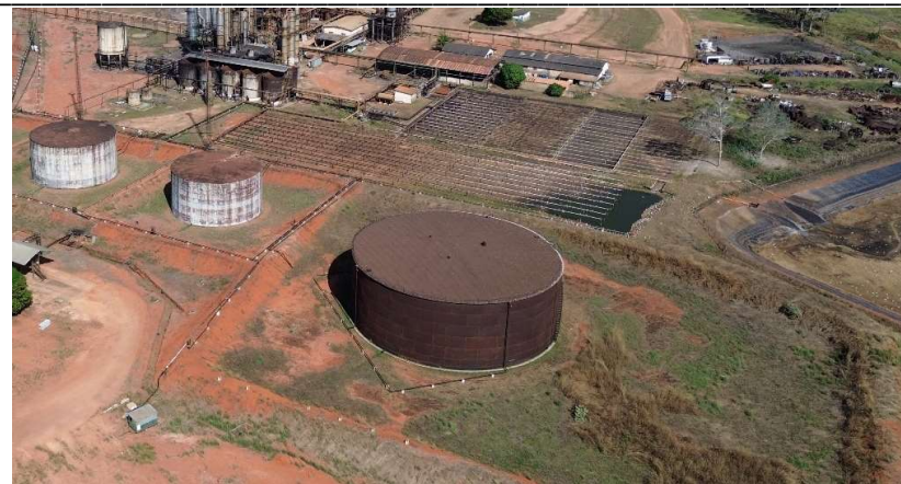
Figura 8 – Base De Concreto Tanque Etanol 20.000 M3 Com Volume De Concreto Da Estrutura 1.387,14 M 3
