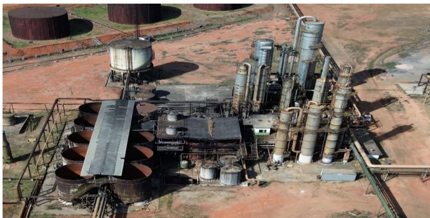
Figura 7 – Base De Concreto Área De Destilaria Com Volume De Concreto Da Estrutura 3.272,04 M 3
