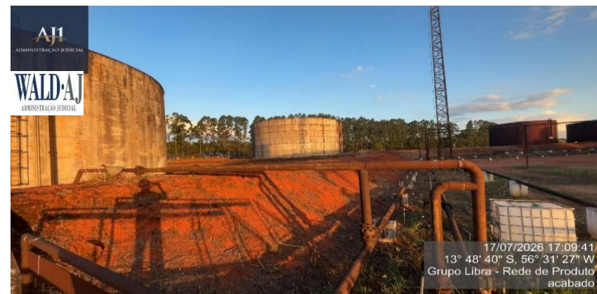
Figura 37 – Rede De Produto Acabado De Alcool C/Tubulação Em Aco Inox C/Diam 4 Pol Comp 400000 Mm - C/Diam 10 Po
