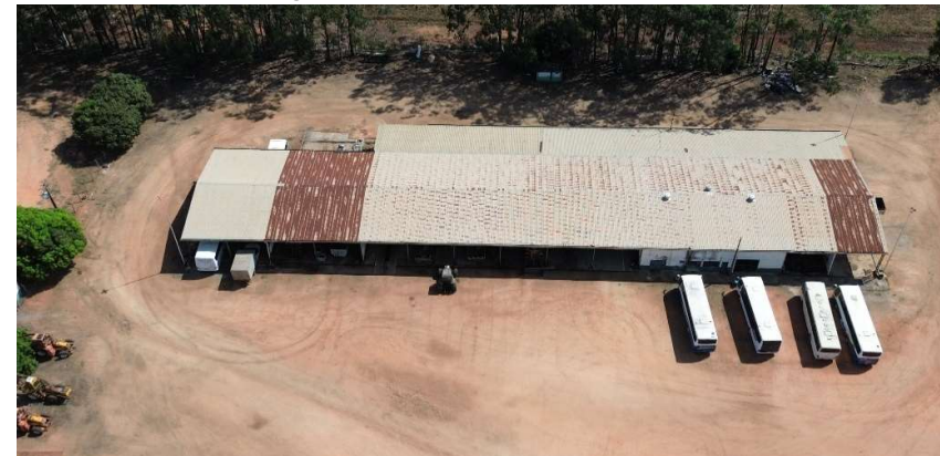
Figura 45 – Galpão Oficina Com Área 2.291,42 M²
