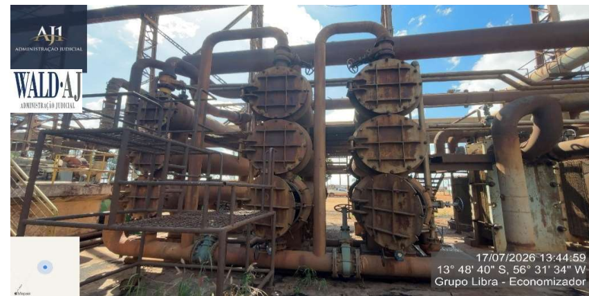
Figura 13 – Economizador E Pre-Aquecedor De Ar 01 Estrutura Em Aço Carbono Dim 6000x6000x10000 Mm
