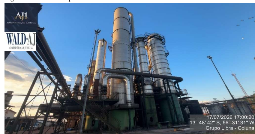
Figura 21 – coluna de destilação estrutura aco inox dim 4000x30000 mm cap 225935 kg m3/h mca imec
