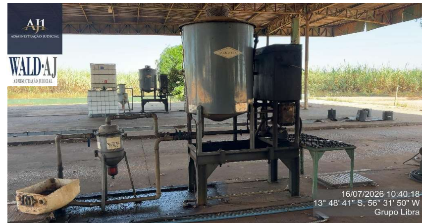
Figura 269 – Unidade De Filtragem Vazão 4300 M3/H Mca Oleofil Mod Of4800.
