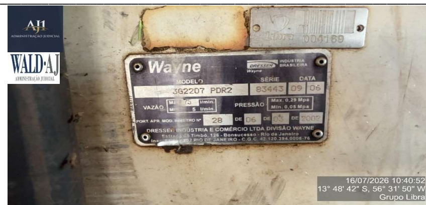
Figura 260 – Bomba De Combustivel Vazão 50 L/Min Mca Wayne Mod 3g2207 P – N ° B 003.
