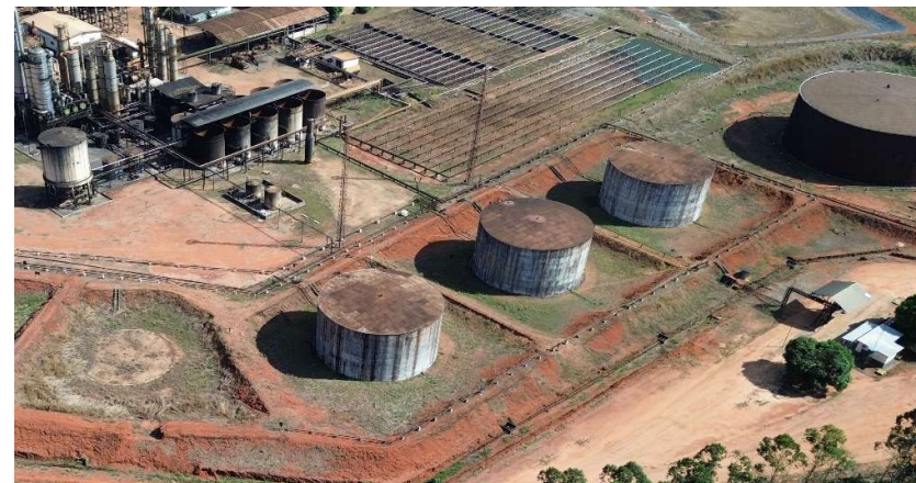
Figura 29 – 3 Unidades De Base De Concreto Tanque 4 Com Volume De Concreto Da Estrutura 421,01 M³
