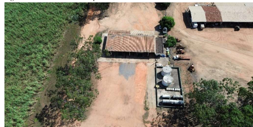
Figura 25 - Base De Concreto Tanques Posto De Combustível Com Volume De Concreto Da Estrutura 472,80 M³
