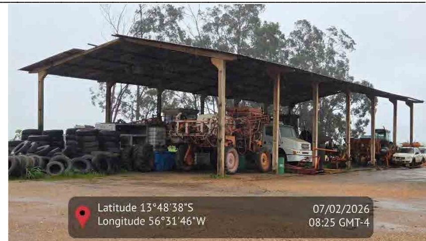
Figura 20 - Imagem do barracão de abrigo dos maquinários
