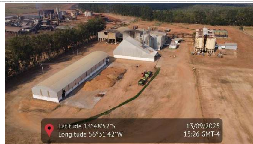
Figura 1769 - Imagem aérea da estrutura da usina de milho
