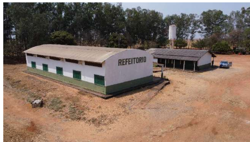
Figura 88 - Imagem aérea do refeitório e alojamentos
