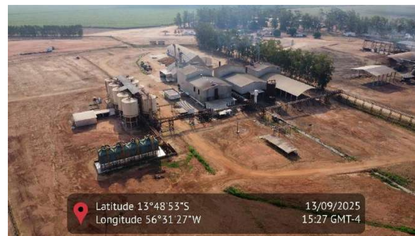
Figura 17780 - Imagem aérea da estrutura da usina de milho
