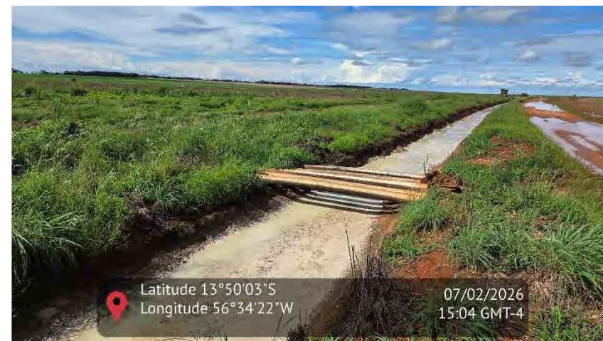
Figura 74 - Imagem da área de reforma (arrendo)
