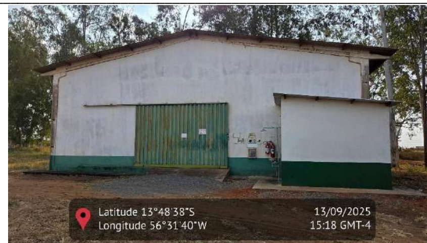
Figura 16871 - Imagem do depósito de produtos químicos
