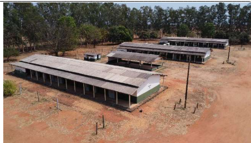
Figura 87 - Imagem aérea dos alojamentos
