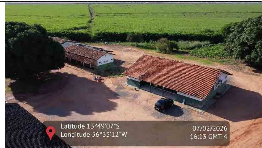
Figura 56 - Imagem aérea dos alojamentos
