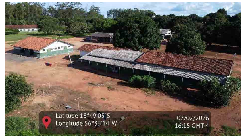
Figura 57 - Imagem aérea dos alojamentos
