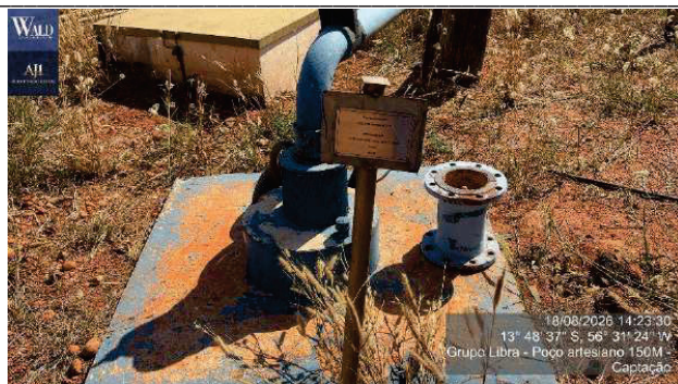
Figura 27 – poço artesiano profundidade 150,00 m diametro 8 pol
