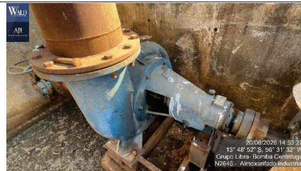
Figura 101 – bomba centrífuga vazão 1000 m3/h diam rotor 600 mm mca equipe mod eq-350-35
