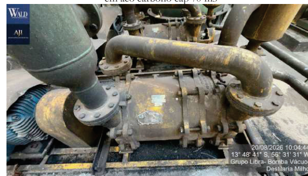
Figura 86 – bomba de vacuo de anel liquido mca dositec mod: dva/h 380/400 vazao 1,500 m³/h vacuo 22 a 26 hg rot
