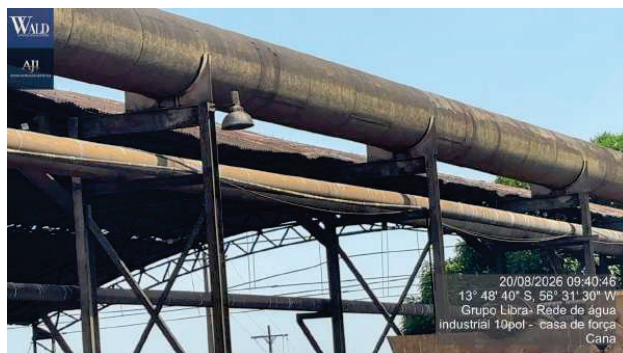
Figura 84 – rede de agua industrial c/tubulacao em aco carbono c/diam 10 pol comp 400000 mm trajeto predominante
