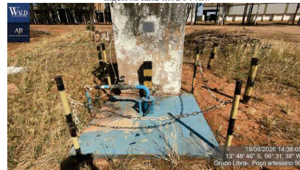
Figura 70 – poço artesiano com profundidade 90,00 m
