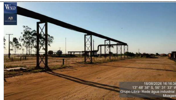
Figura 49 – rede de água industrial c/tubulacao em aco carbono c/diam 16 pol comp 400000 mm trajeto predominante
