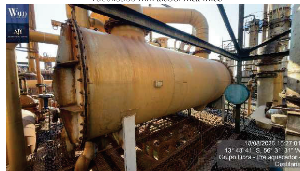
Figura 34 – 2 Unidade de aquecedor de vinho estrutura em aço inox cap 300 m2 diam 1400x6000 mm mca conger
