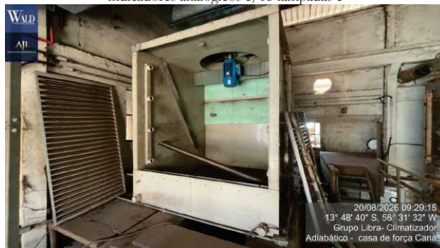
Figura 80 – climatizador adiabático estrutura em polipropileno dim 2000x2000x3000 mca gw
