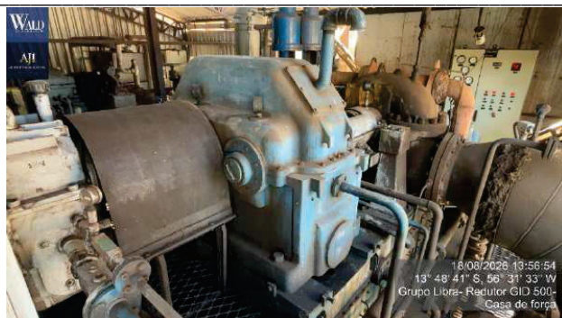
Figura 23 – redutor de velocidade relacao 7014-1800 mca dedini mod gid.500
