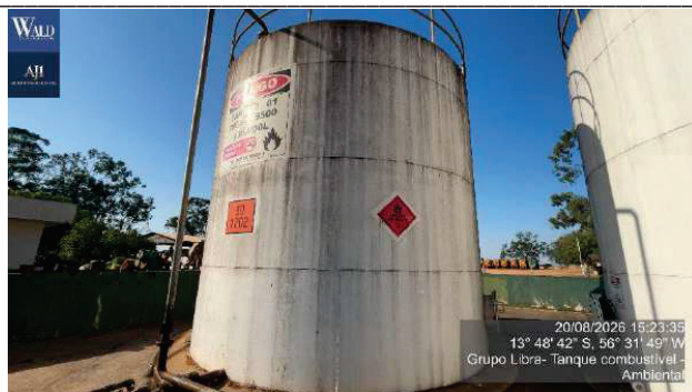
Figura 103 – tanque cilíndrico horizontal p/combustível estrutura em aço carbono cap 130 m3
