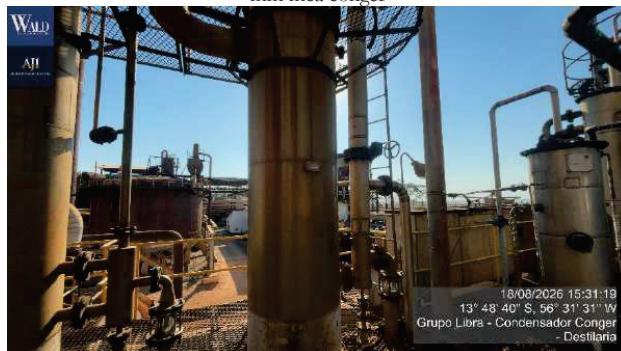
Figura 36 – 2 Unidade de condensador auxiliar estrutura em aco inox cap 72 m2 diam 1200x4000 mm mca conger
