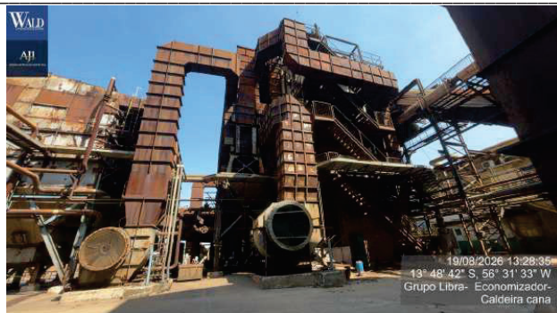
Figura 63 – 2 Unidade de economizador e pre-aquecedor de ar 02 estrutura em aco carbono dim 2000x6000x10000 mm
