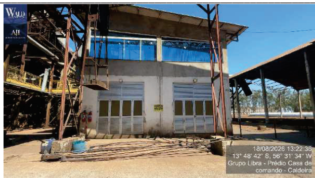
Figura 11 – predio casa de comandos caldeira com área privativa 346,58 m²
