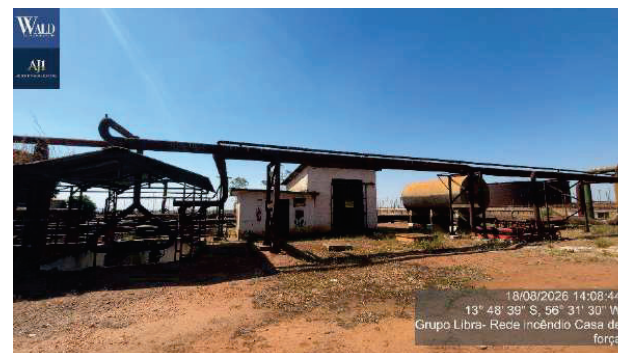
Figura 26 – rede de incendio c/tubulacao em aco carbono c/diam 4 pol comp 1500000 mm trajeto predominante aereo
