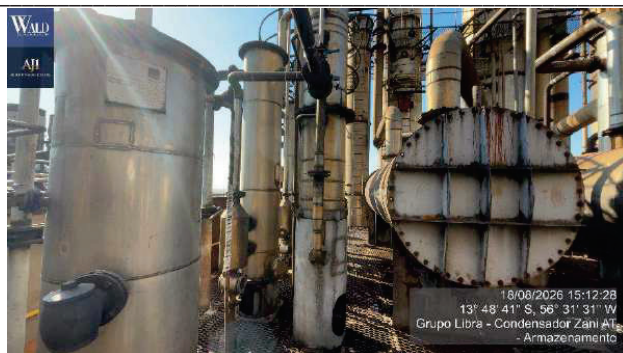
Figura 31 – condensador estrutura em aço inox cap 150000l/24 h diam 1400x6000 mm mca zanini mod zani-at
