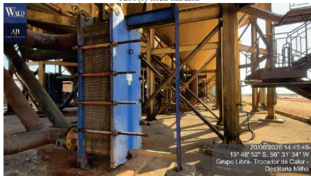
Figura 100 – 5 Unidades de trocador de calor estrutura aco carbono vertical dim 900x1700x2500 mm area de troca 284-14 l mca tra
