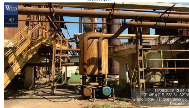
Figura 94 – tanque cilindrico horizontal p/agua estrutura em aco inox cap 84 m3
