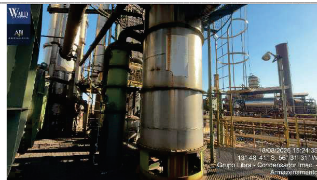
Figura 33 – 4 Unidade de condensador estrutura em aço inox cap 5-8 m3 diam 1500x3300 mm alcool mca imec
