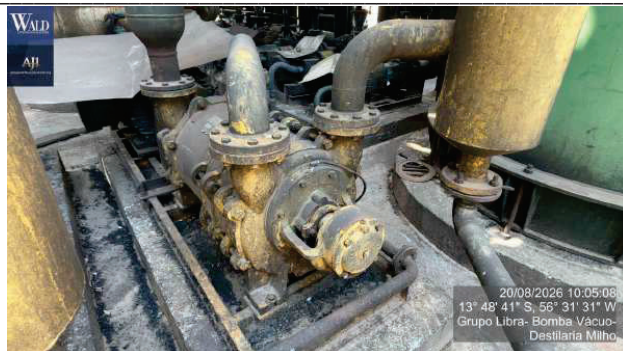
Figura 87 – bomba de vacuo de anel liquido mca dositec mod: dva/h 380/400 vazao 1,500 m³/h vacuo 22 a 26 hg rot
