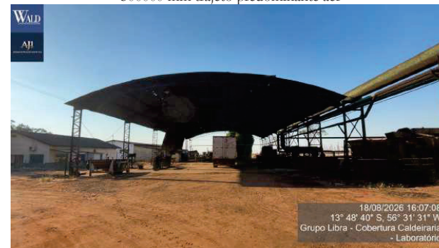
Figura 46 – cobertura calderaria com área 834,26 m 2
