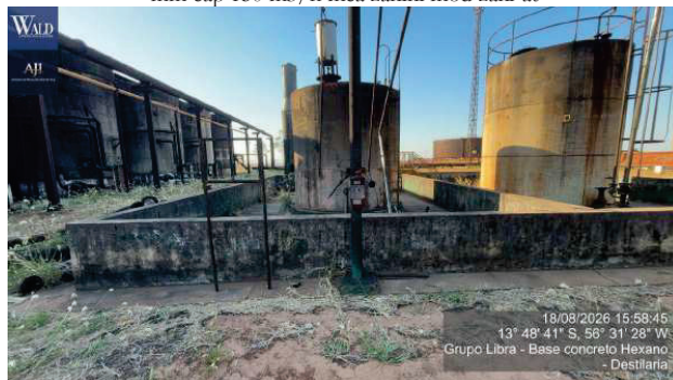
Figura 44 – base de concreto reservatório hexano com volume de concreto da estrutura 99,16 m 3
