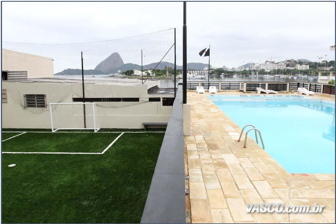
Sede do Calabouço
