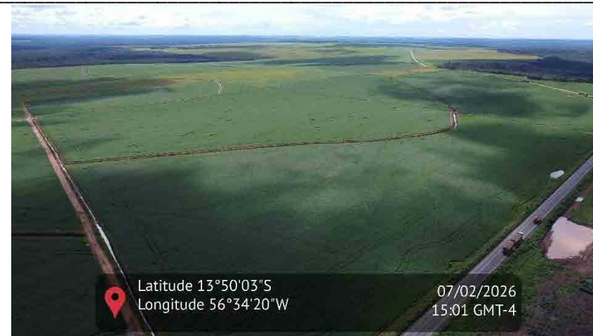
Figura 61 - Imagem aérea da área de reforma com soja (arrendo)
