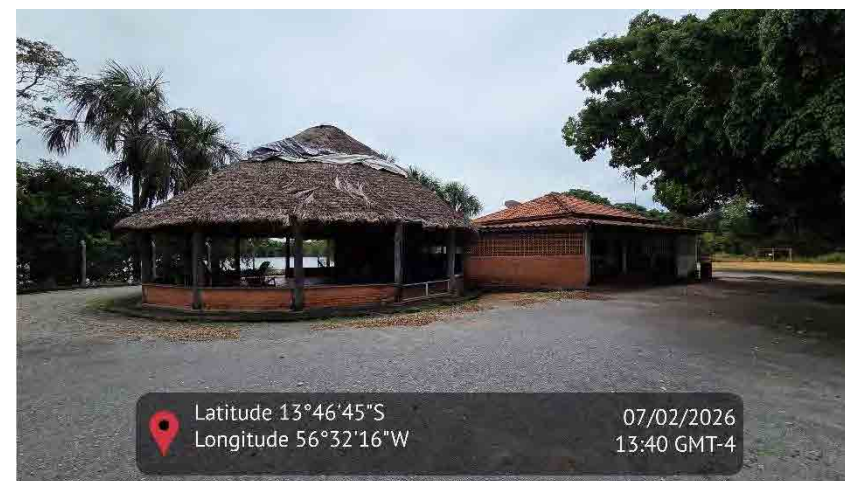
Figura 29 - Imagem do refeitório e área de lazer da sede retiro
