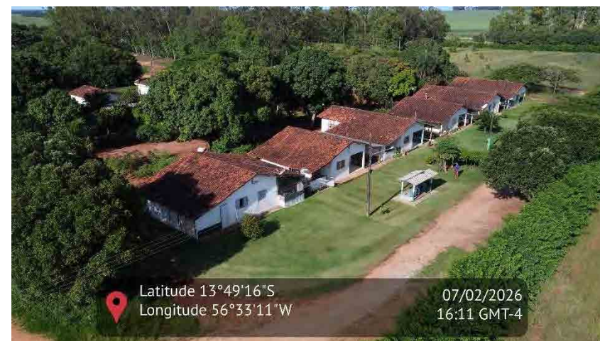
Figura 53 - Imagem aérea das casas de moradia
