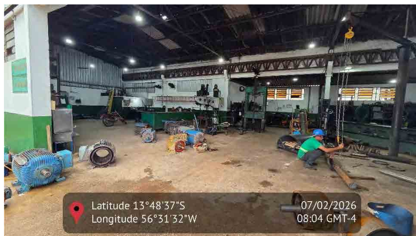
Figura 167 - Imagem da oficina industrial da usina
