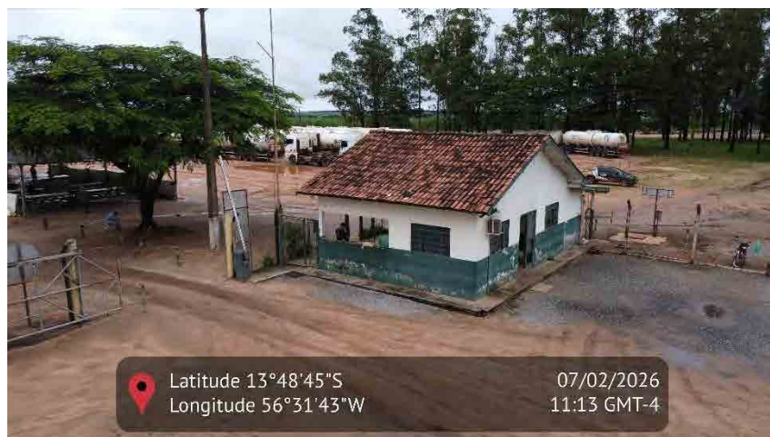
Figura 163 - Imagem aérea da guarita de entrada
