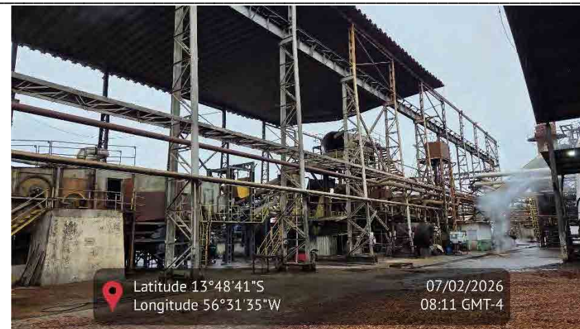
Figura 176 - Imagem da estrutura de moagem da cana
