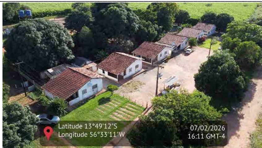
Figura 54 - Imagem aérea das casas de moradia
