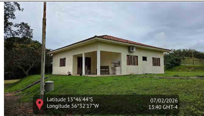
Figura 28 - Imagem da casa da sede retiro
