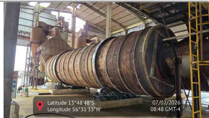
Figura 188 - Imagem da caldeira em funcionamento
