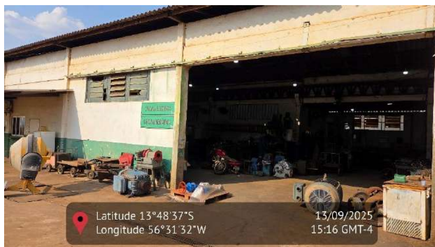
Figura 1646 - Imagem da oficina industrial da usina
