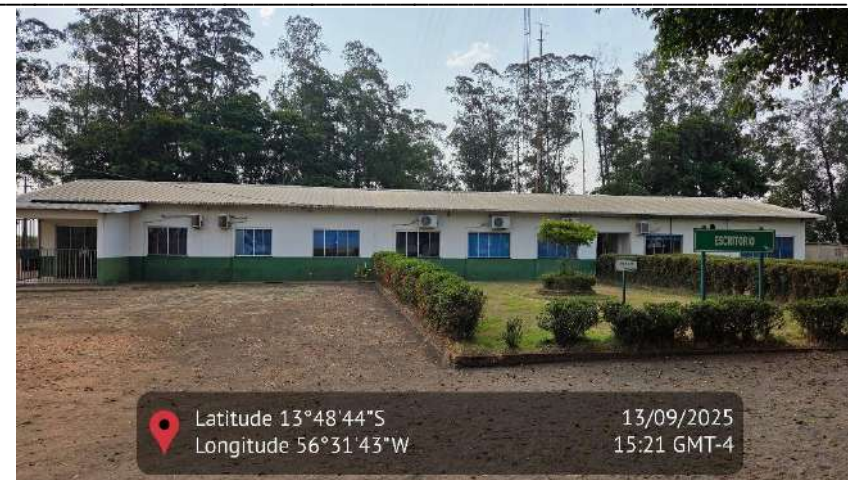
Figura 1725 - Imagem da estrutura de escritório da usina
