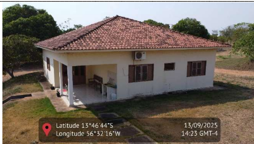
Figura 36 - Imagem da casa de moradia da propriedade
