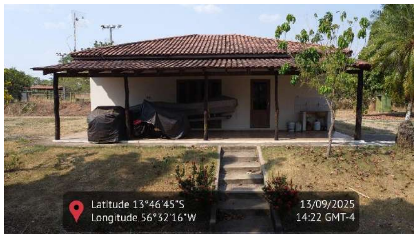
Figura 37 - Imagem da casa de moradia da propriedade
