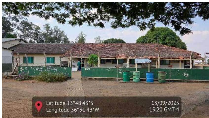
Figura 1714 - Imagem da estrutura de refeitório da usina
