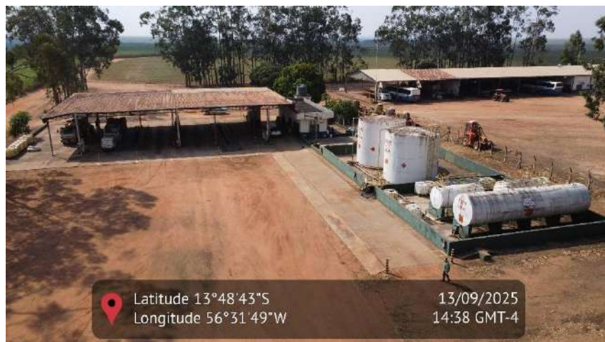
Figura 33 - Imagem aérea do posto de combustível da propriedade
