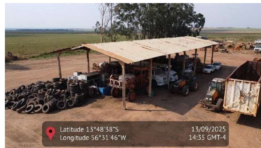
Figura 27 - Imagem aérea do galpão de abrigo de máquinas
