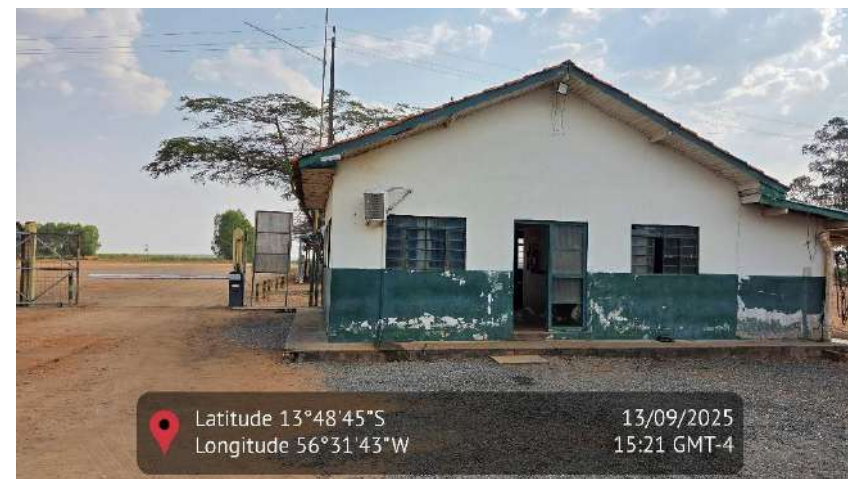
Figura 1736 - Imagem da portaria da usina
