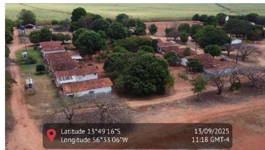
Figura 64 - Imagem aérea das casas de moradia
