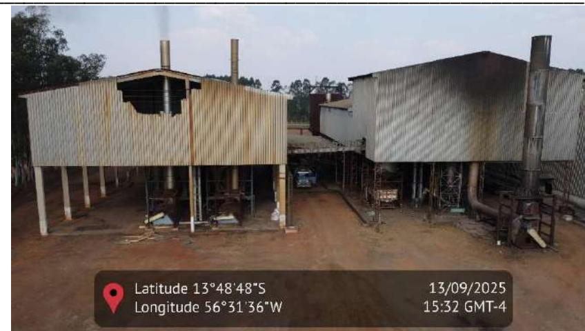
Figura 18083 – Imagem aérea da estrutura de caldeiras da usina
