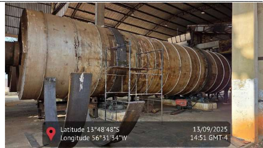
Figura 1847 - Imagem da caldeira em manutenção
