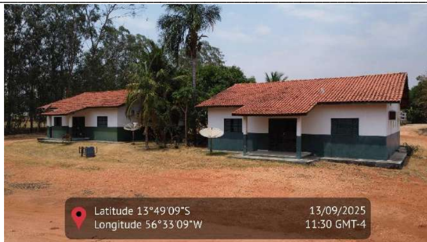
Figura 65 - Imagem das casas de moradia
