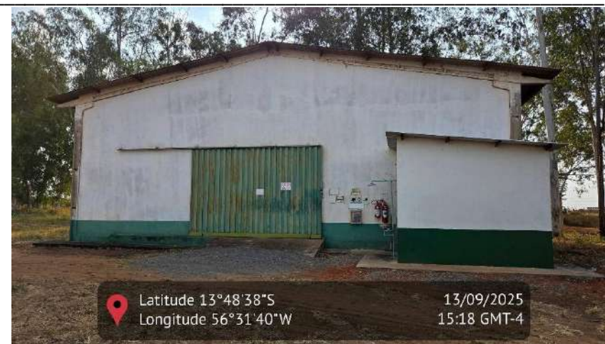
Figura 16871 - Imagem do depósito de produtos químicos
