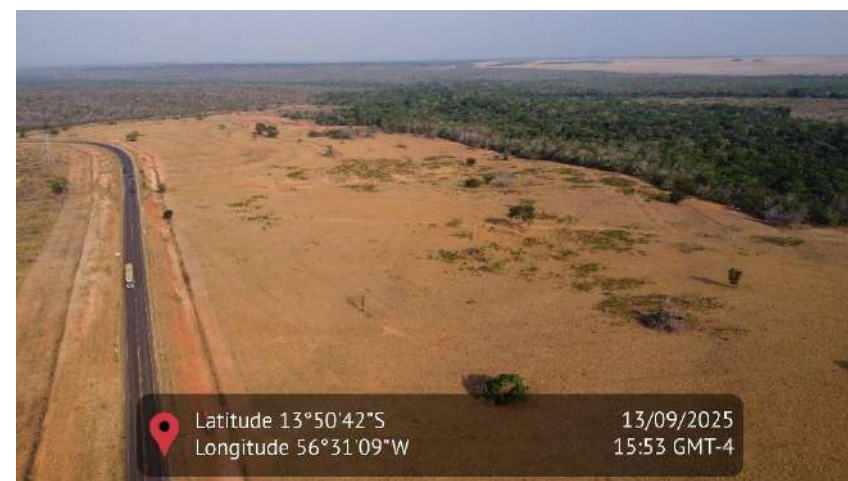
Figura 97 - Imagem aérea da área de pastagem (desativada)
