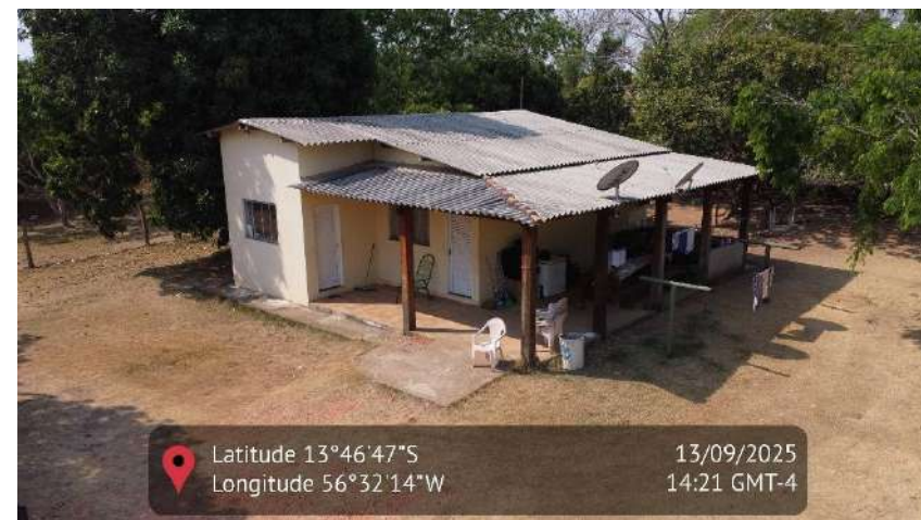
Figura 35 - Imagem da casa do funcionário da propriedade
