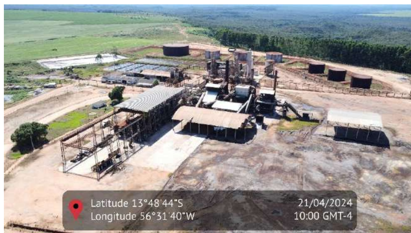
193 – Imagem aérea estrutura da usina (cana de açúcar)
