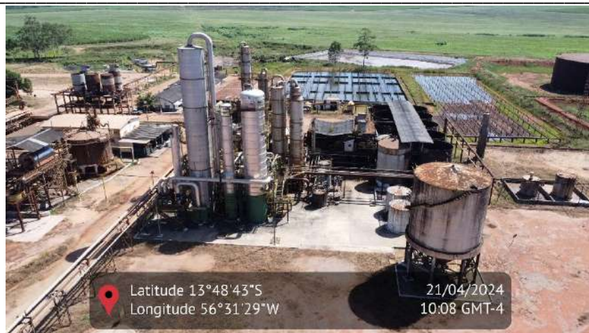
196 – Imagem aérea estrutura da usina (cana de açúcar)
