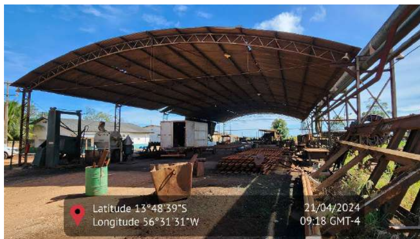
209 – Imagem da oficina mecânica da usina (cana de açúcar)
