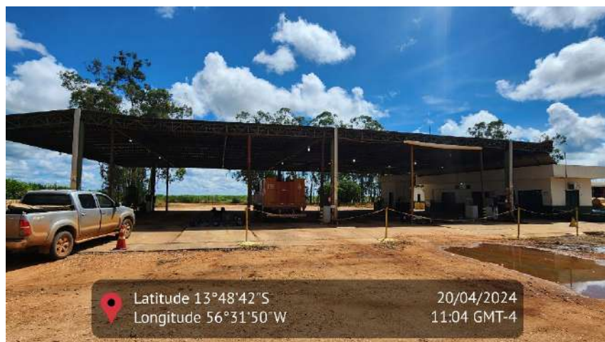
32 – Imagem do posto de combustível da fazenda
