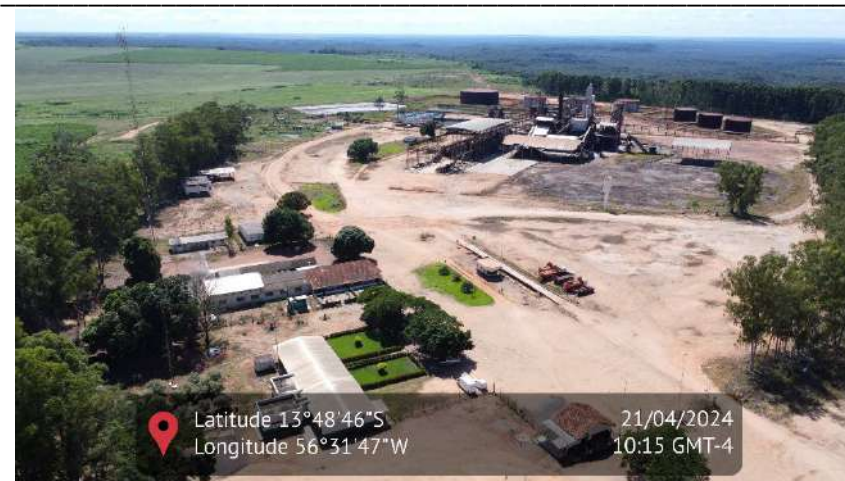
190 – Imagem aérea da usina (cana de açúcar)
