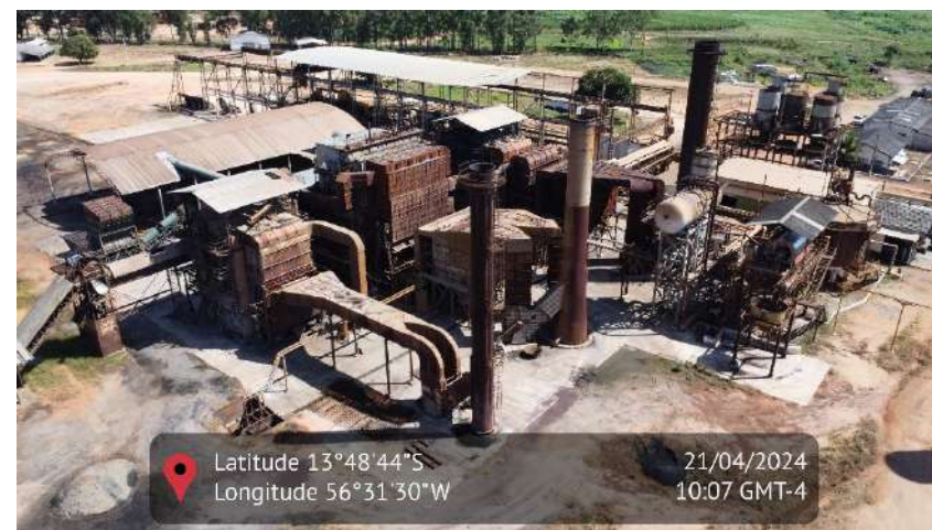
195 – Imagem aérea estrutura da usina (cana de açúcar)
