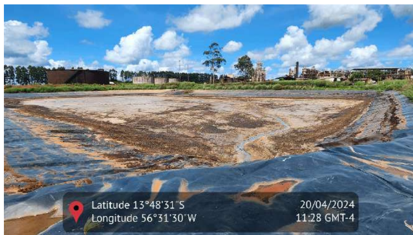
48 – Imagem do tanque de armazenamento de vinhaça da usina
