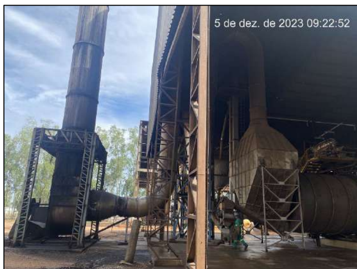
Foto 37: Vista parcial in loco da Sede.
