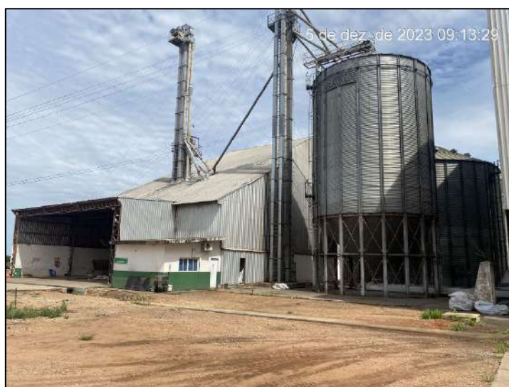
Foto 30: Vista parcial in loco da Sede.
