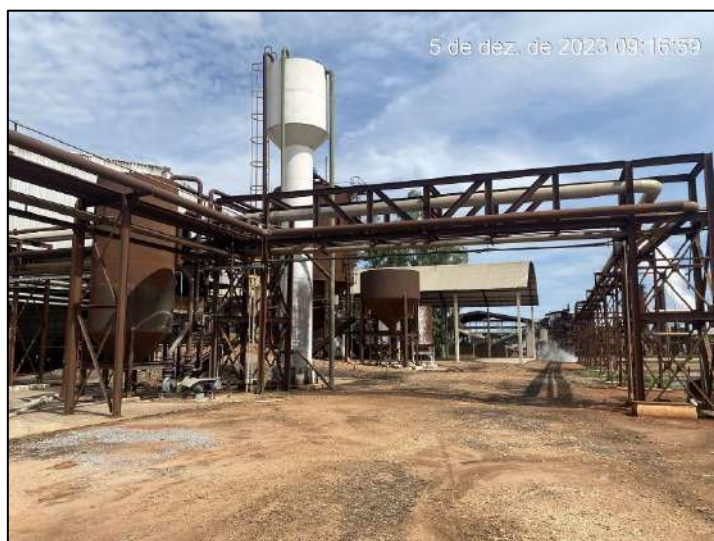
Foto 45: Vista parcial in loco da Sede.
