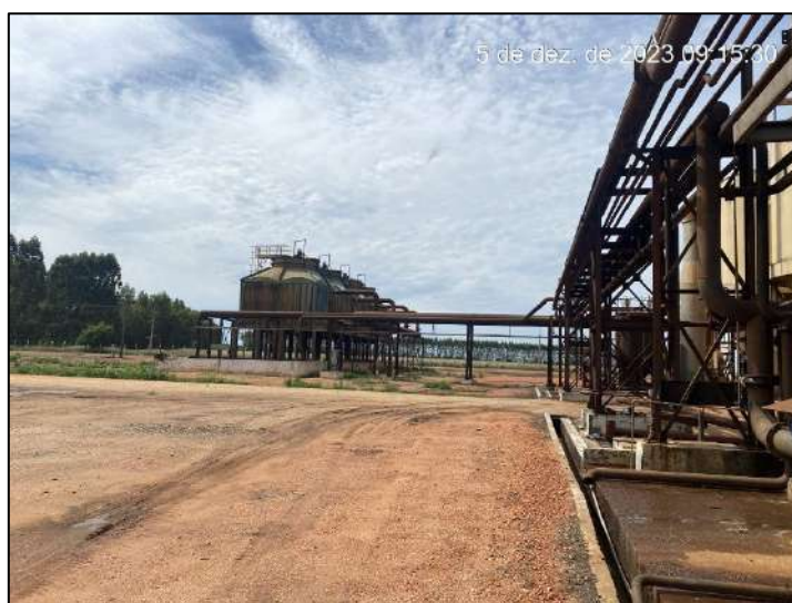
Foto 48: Vista parcial in loco da Sede.
