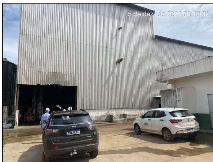
Foto 49: Vista parcial in loco da Sede.
