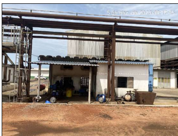
Foto 44: Vista parcial in loco da Sede.
