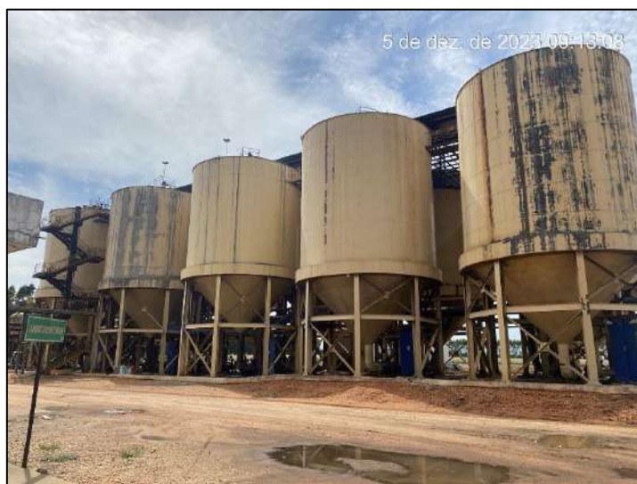
Foto 53: Vista parcial in loco da Sede.
