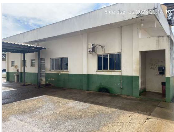
Foto 50: Vista parcial in loco da Sede.
