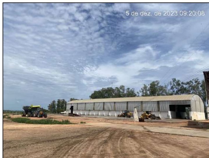
Foto 42: Vista parcial in loco da Sede.
