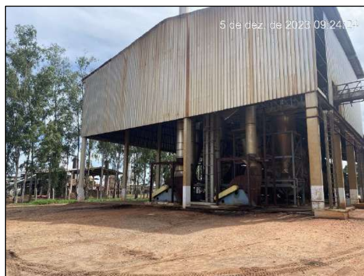
Foto 38: Vista parcial in loco da Sede.
