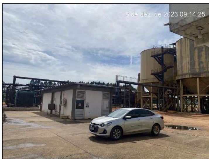
Foto 52: Vista parcial in loco da Sede.
