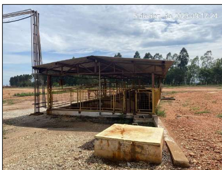
Foto 46: Vista parcial in loco da Sede.
