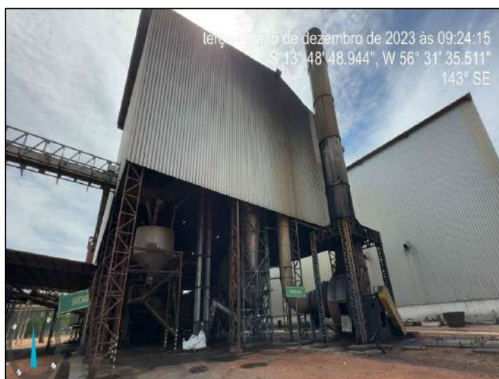
Foto 32: Vista parcial in loco da Sede.
