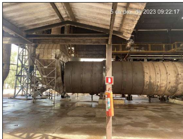
Foto 40: Vista parcial in loco da Sede.
