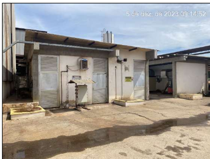
Foto 51: Vista parcial in loco da Sede.
