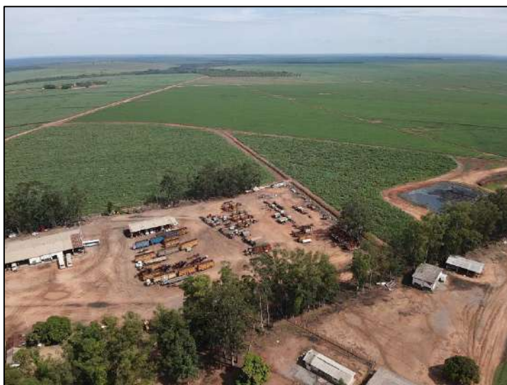
Foto 08: Vista panorâmica parcial da Sede.
