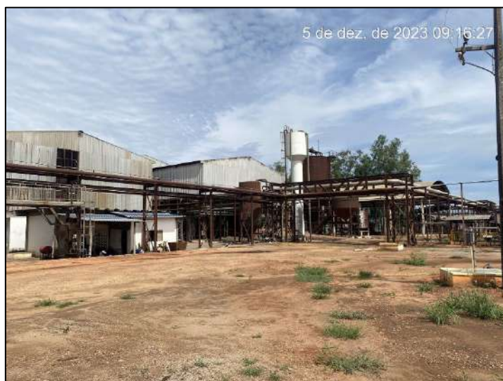
Foto 47: Vista parcial in loco da Sede.
