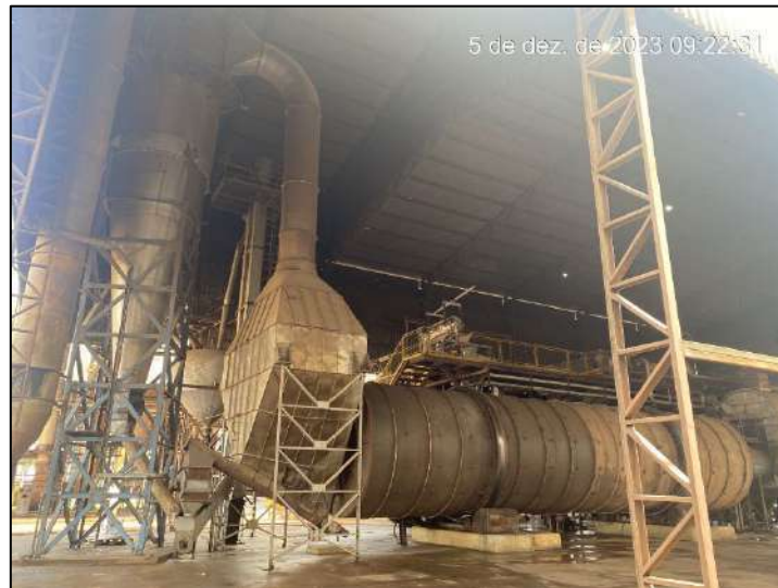
Foto 39: Vista parcial in loco da Sede.
