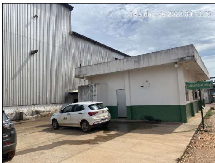
Foto 29: Vista parcial in loco da Sede.
