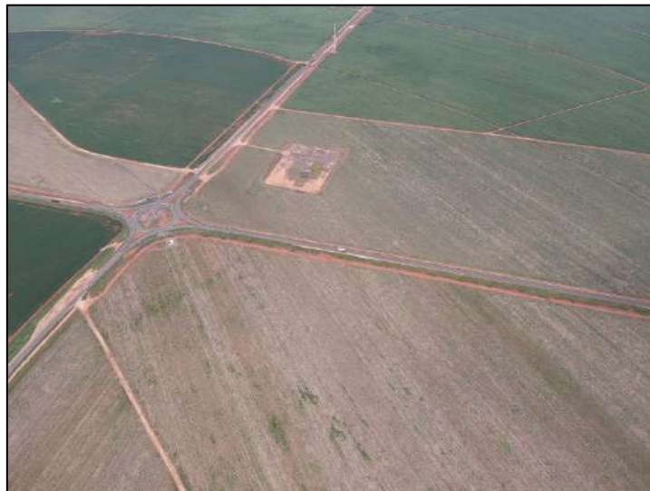
Foto 13: Vista parcial panorâmica da estrada.
