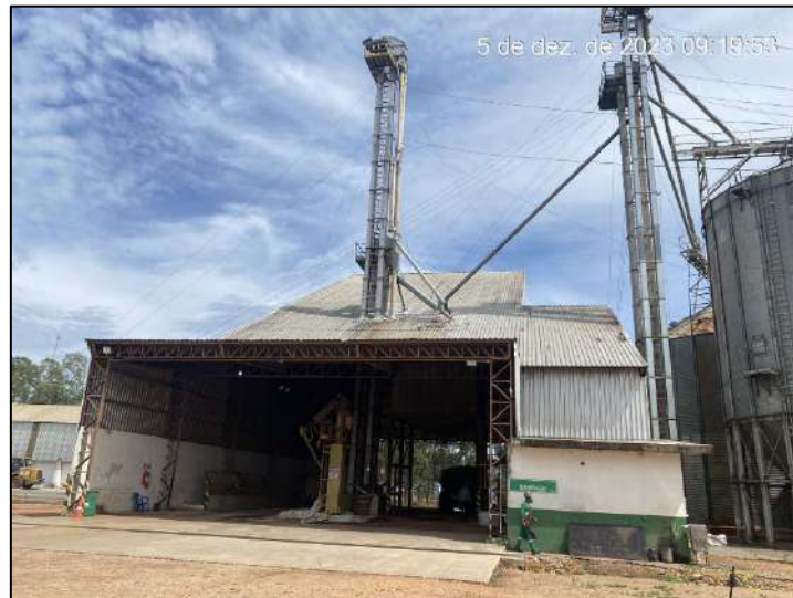
Foto 41: Vista parcial in loco da Sede.
