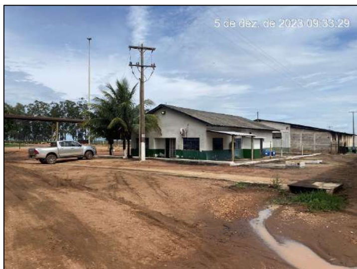
Foto 01: Vista parcial in loco da Sede - Destilaria.
