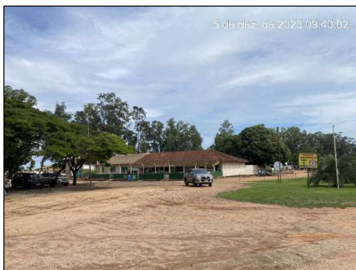
Foto 10: Vista parcial no interior da Sede – Destilaria.
