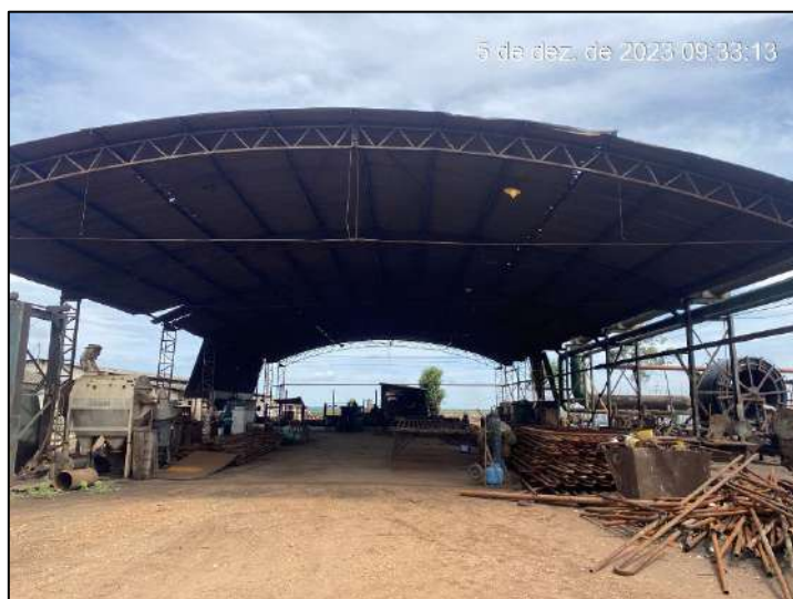
Foto 03: Vista de galpão de depósito de materiais e maquinários.
