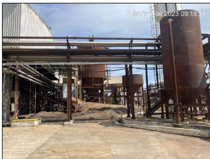
Foto 43: Vista parcial in loco da Sede.
