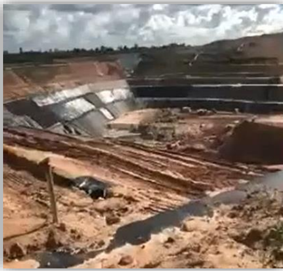
11. Aterro sanitário de Maceió - AL
